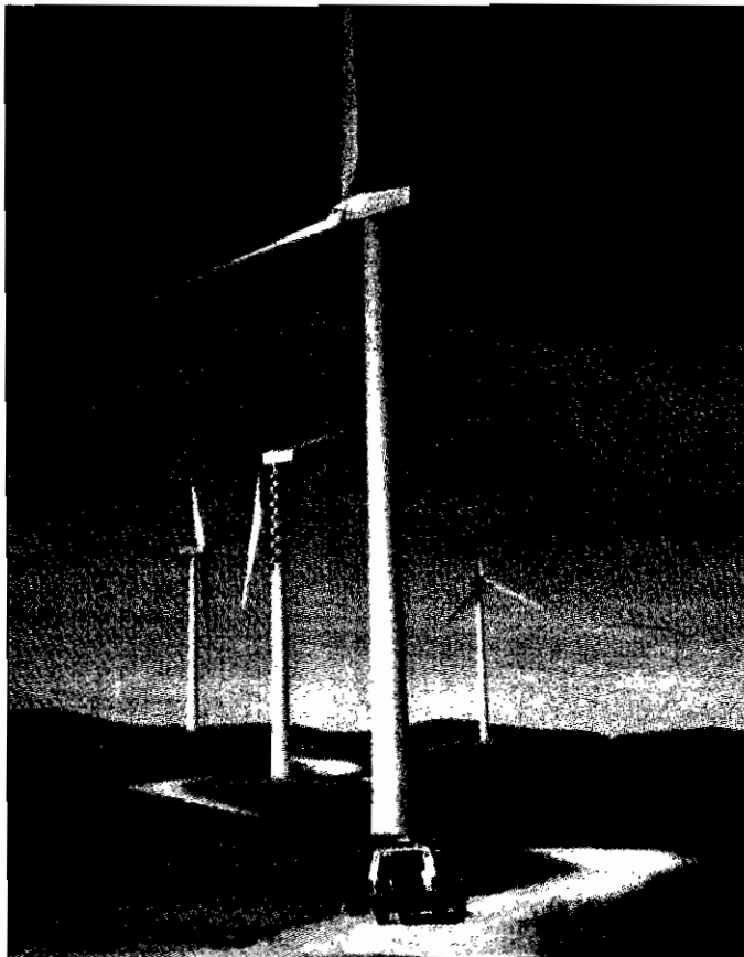
Un impianto eolico nei pressi di Nicosia
