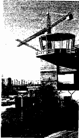
Il cantiere dell'aeroporto
