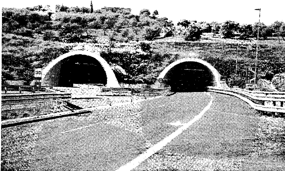
Un tratto dell'autostrada nella zona di Rosolini FOTO CIMI
