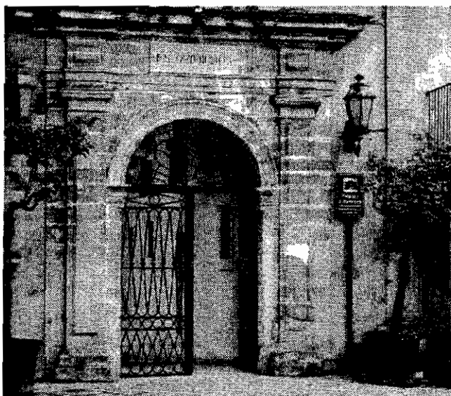
L'ingresso del Palazzo municipale
