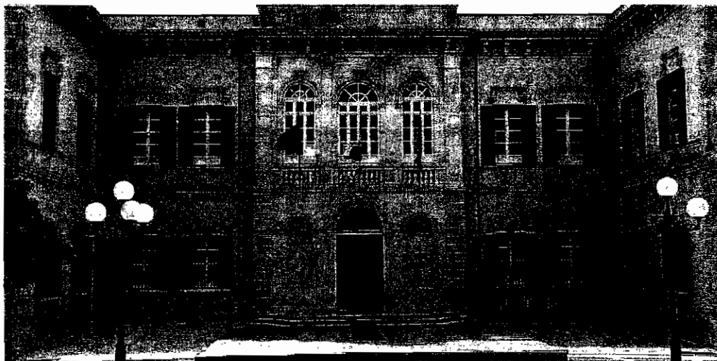
Si profilano novità importanti a palazzo La Pira sede del Comune di Pozzallo
