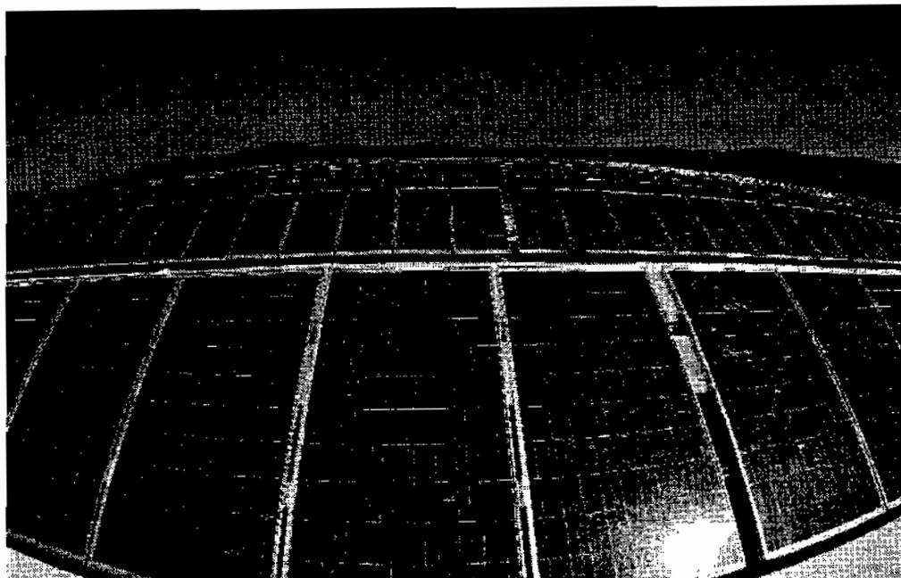
Pannelli fotovoltaici sopra il tetto di un edificio
