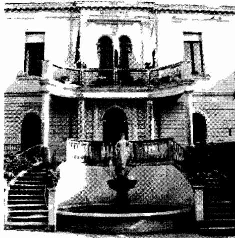
Il Palazzo municipale di Chiaramonte Gulf
