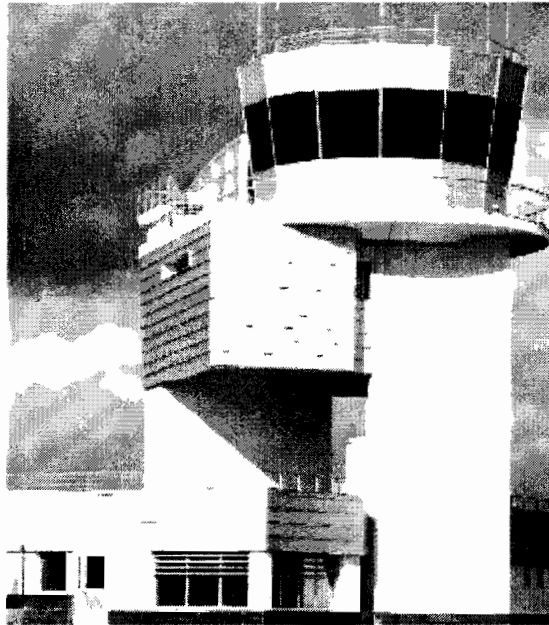
La torre di controllo dell'aeroporto di Comiso
