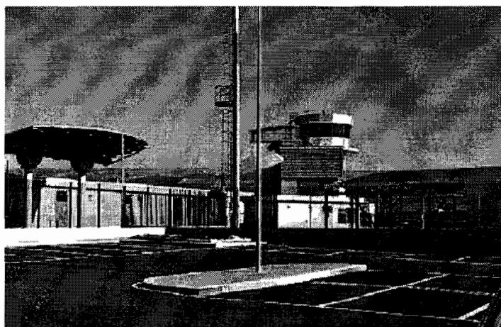
Le strutture dell'aeroporto Magliocco
