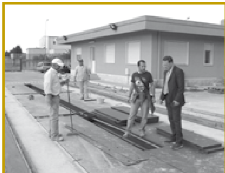
L'assessore Minardi segue i lavori di realizzazione della pesa pubblica
