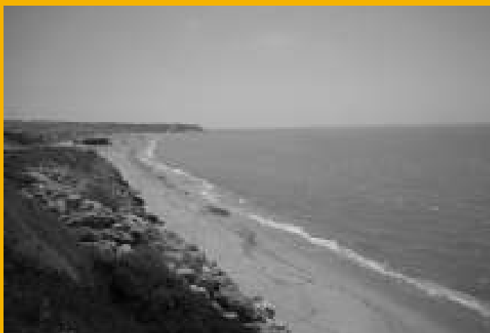
Scoglitti. La spiaggia di Cammarana soggetta ad erosione
