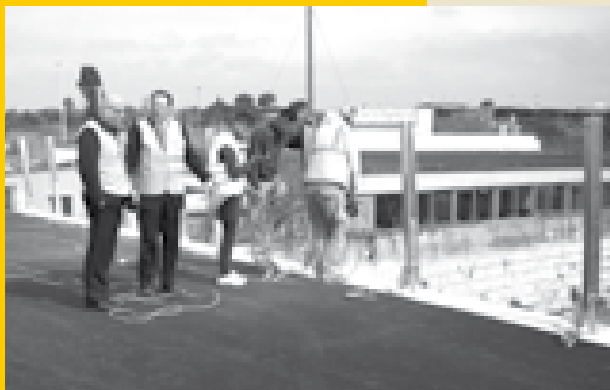
Il sopralluogo di Moltisanti e Minardi per i lavori sul ponte
