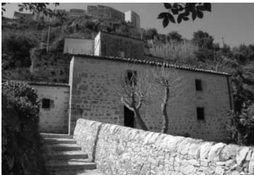
<Il vecchio mulino di contrada San Rocco dopo l'intervento di ristrutturazione>
