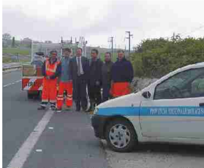
I lavori di ripristino della segnaletica stradale orizzontale nella S.P. 10 Annunziata-Maltempo
