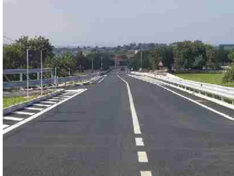
La S.P. 60 Ragusa-Malavita dopo gli interventi di manutenzione straordinaria
