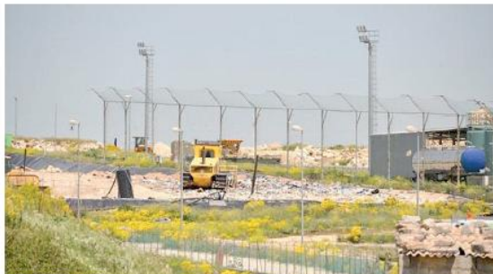
L'impianto di Cava dei modicani lungo la Sp Chiamonte maltempo
