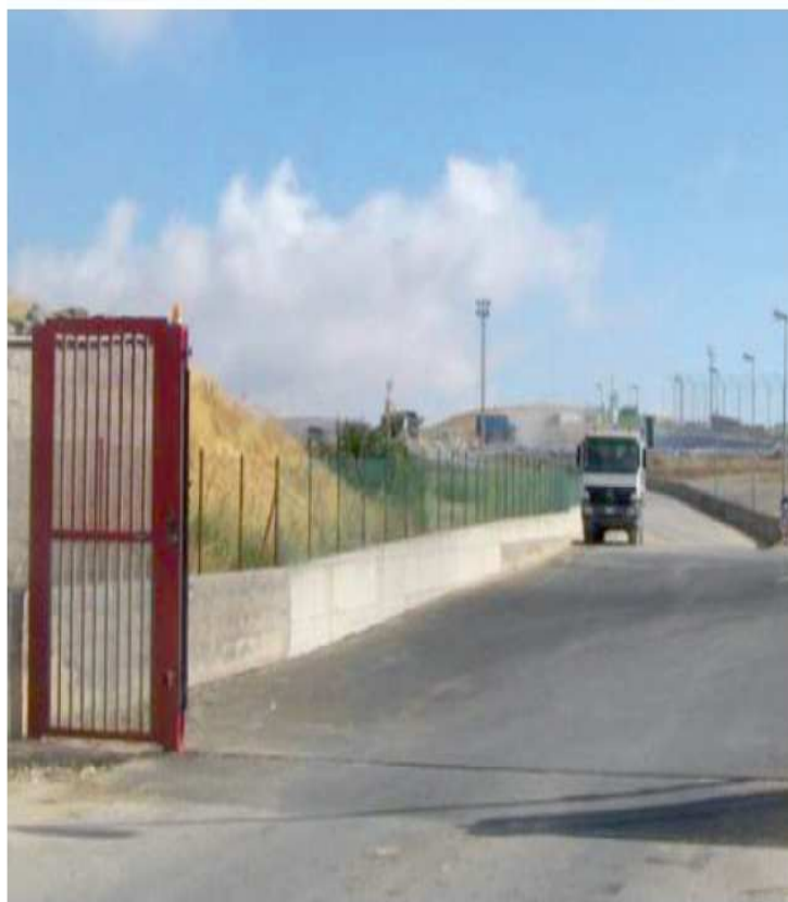
L'ingresso di Cava dei Modicani dove si registrano ancora anomalie
