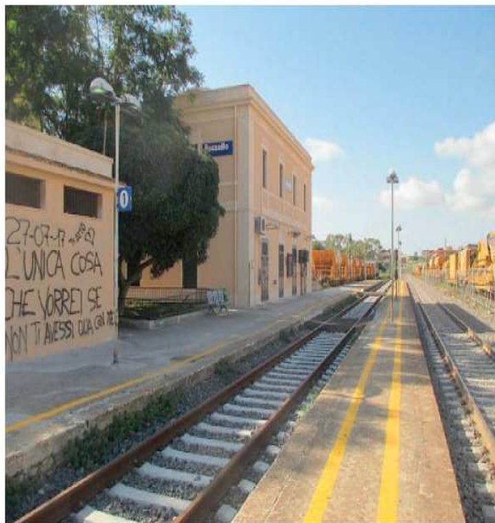
La stazione ferroviaria ha bisogno di interventi di riqualificazione
