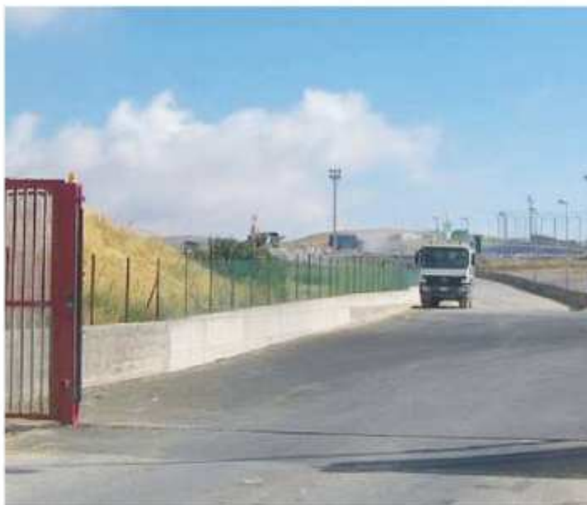
Rifiuti. L'ingresso della discarica di Cava dei Modicani
