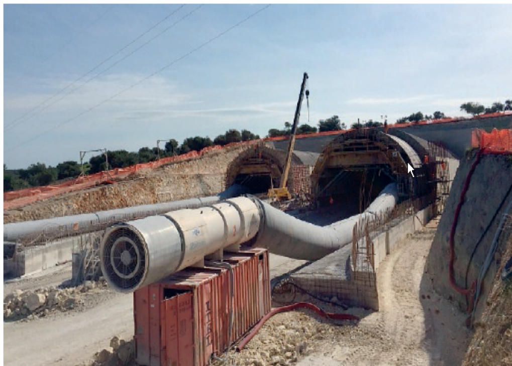
Il cantiere per la realizzazione della Rosolini-Modica.
