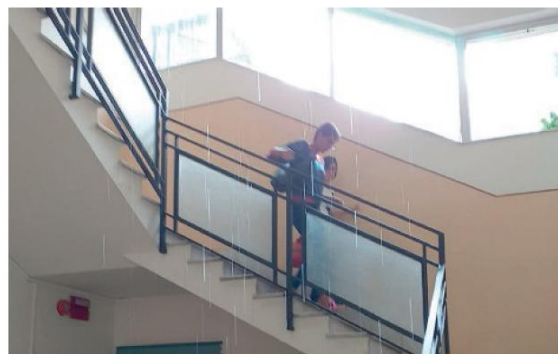
Sopra alcune macchie d'umidità in un corridoio dell'ospedale. Sotto, la situazione che si verifica all'interno ogni qualvolta piove
