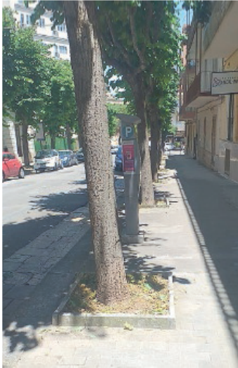
Un viale alberato dopo l'intervento
