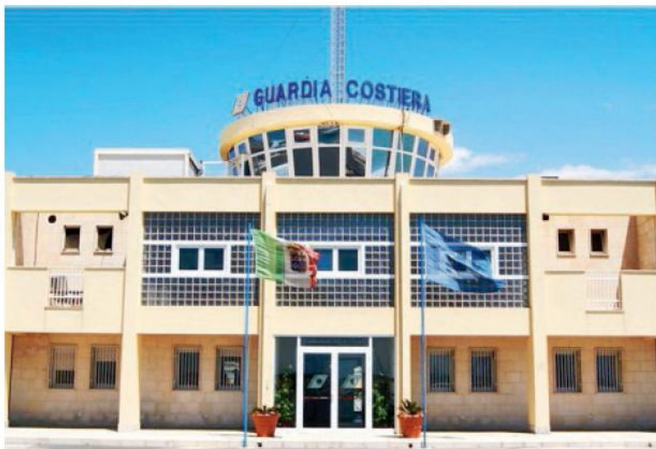
Controlli serrati della Capitaneria di porto all'interno della struttura
