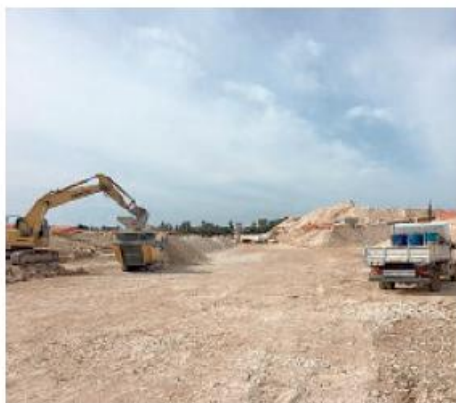
Il cantiere della Rosolini-Modica
