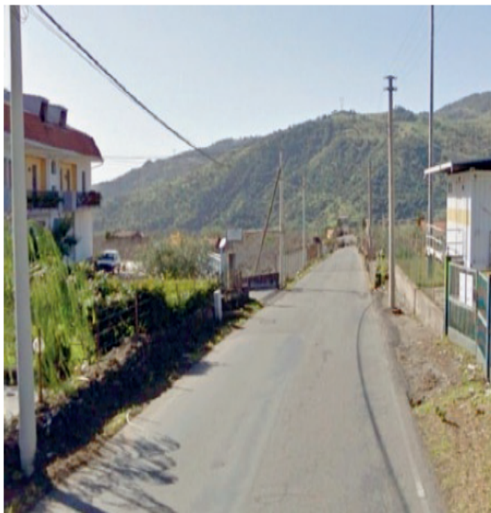
UN TRATTO DELLA STATALE BRONTE-ADRANO: VIA LIBERA ALL'AMMODERNAMENTO
