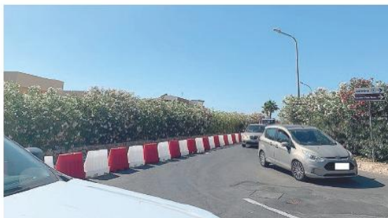
I guardrail installati giovedì per le variazioni al senso unico
