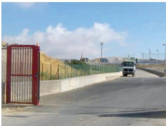
L'ingresso della discarica di Cava dei modicani. Sopra, il sito
